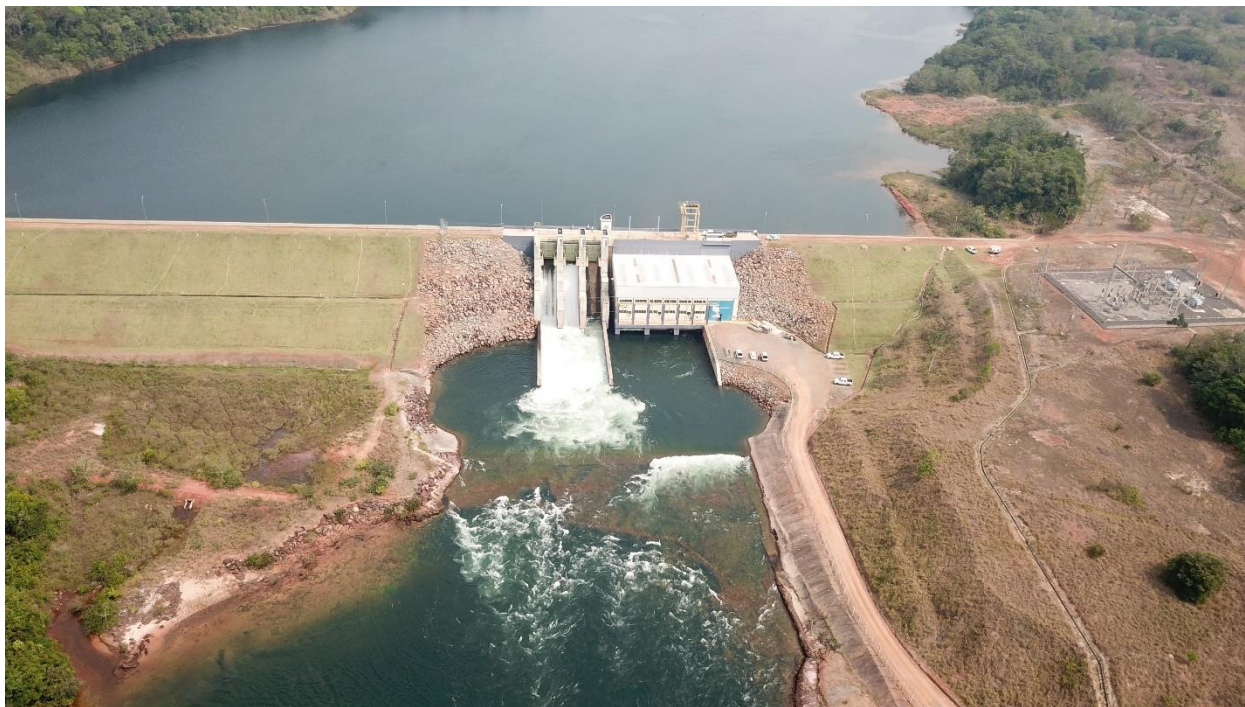
Figura 13 – Vista Geral do Barramento
