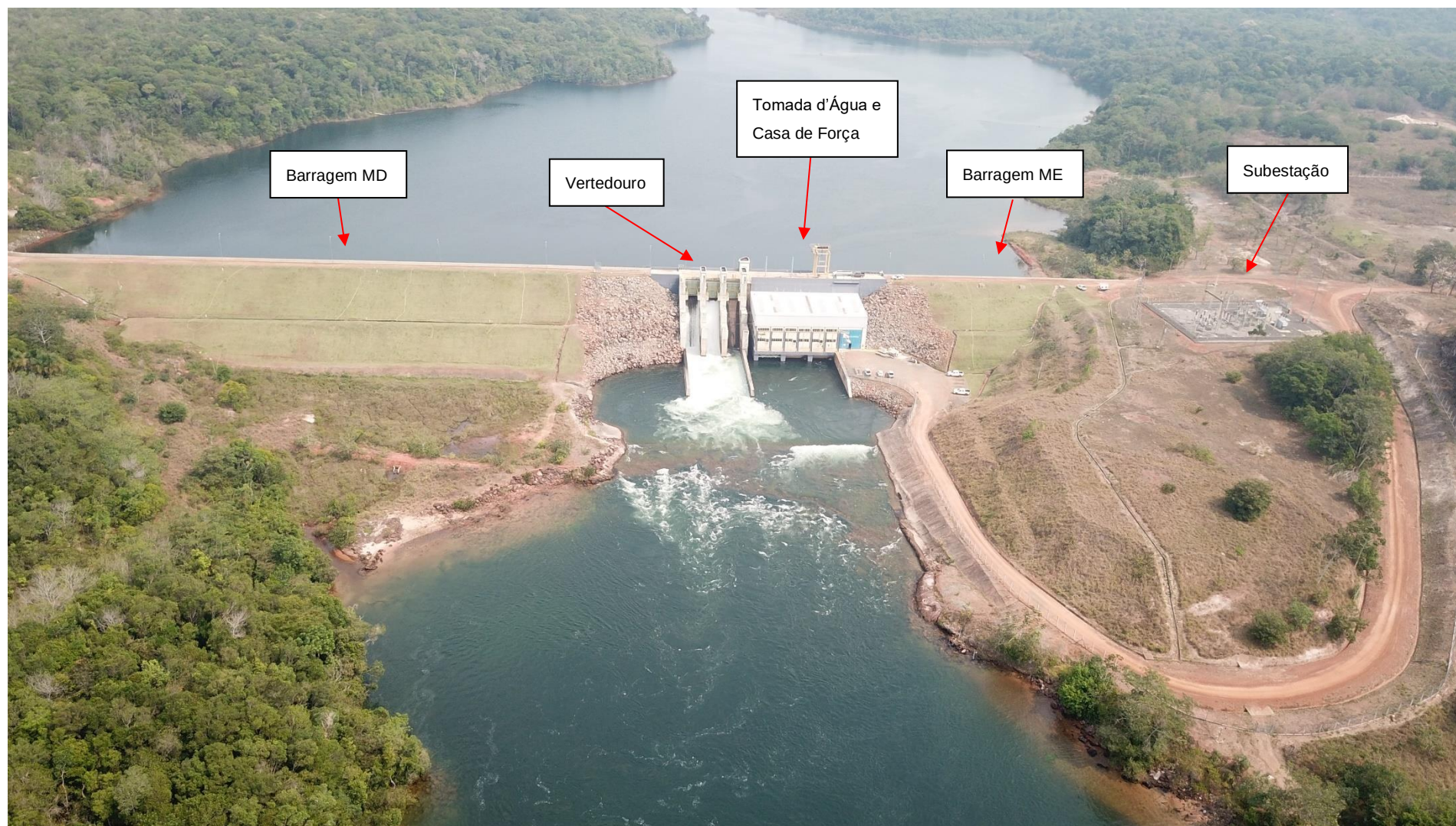
Figura 1 – Foto das estruturas civis – PCH Telegráfica
